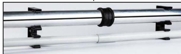
TUYAUTERIE SOUS VIDE ET DE SERVICE
