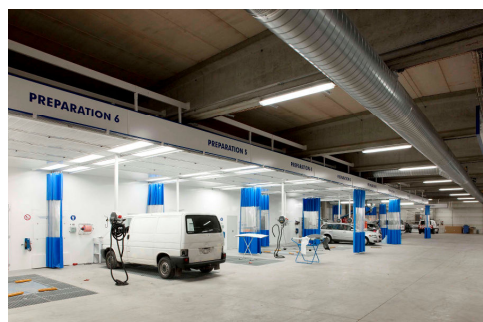
Wonitrol Nivelles (Aménagement d'une carrosserie complète)
